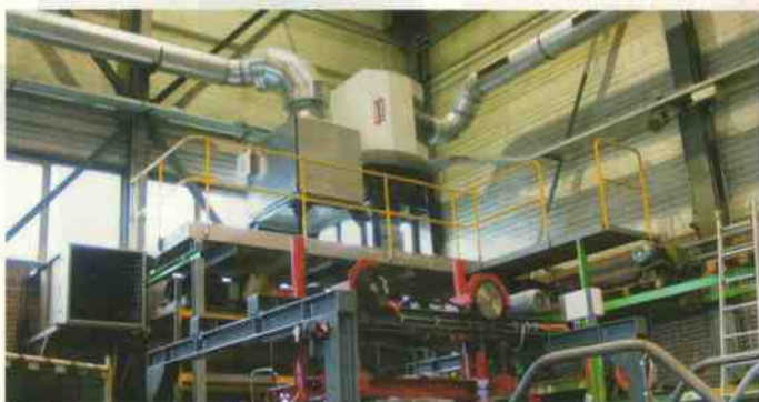
Een nieuw ventilatie- en verwarmingssysteem is voor het schilderwerk een enorme vooruitgang. Temperatuur en luchtstroming zijn belangrijk voor de doordroging
