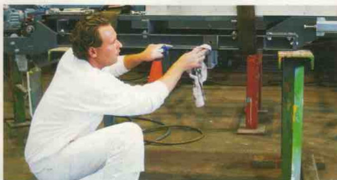
Schilder Robin van der Ven kreeg het ingeprent: eerst reinigen en ontvetten. Voor een goede hechting is dat dé voorbereiding voor watergedragen verfsystemen op metaal
